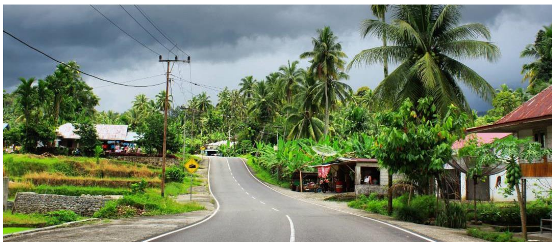
Gambar 3. 9 Pembangunan Jalan Provinsi
